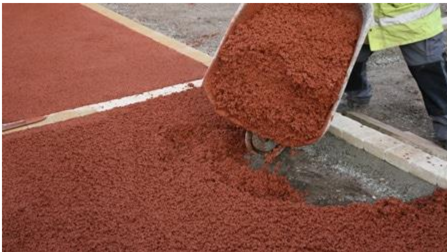
Chantier utilisant du béton drainant. Photo issu du magazine « Info BPE et pompage » de mai 2018
